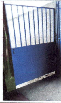
FOTO No. 2 COLOCACIÓN DE PUERTA
