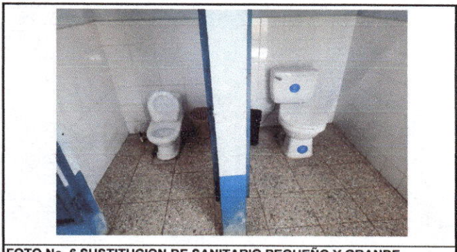
FOTO No. 6 SUSTITUCION DE SANITARIO PEQUEÑO Y GRANDE
