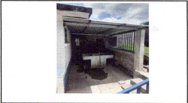
FOTO No. 2 MEJORAMIENTO DE MURO, PILA, Y TECHO.
