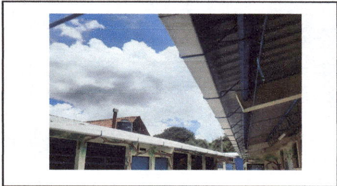
FOTO No. 3 MEJORAMIENTO DE CANALES
