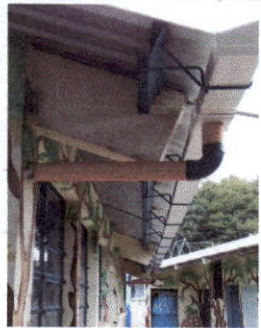
FOTO No. 3 COLOCACIÓN DE TUBO DE BAJADA DE AGUA
